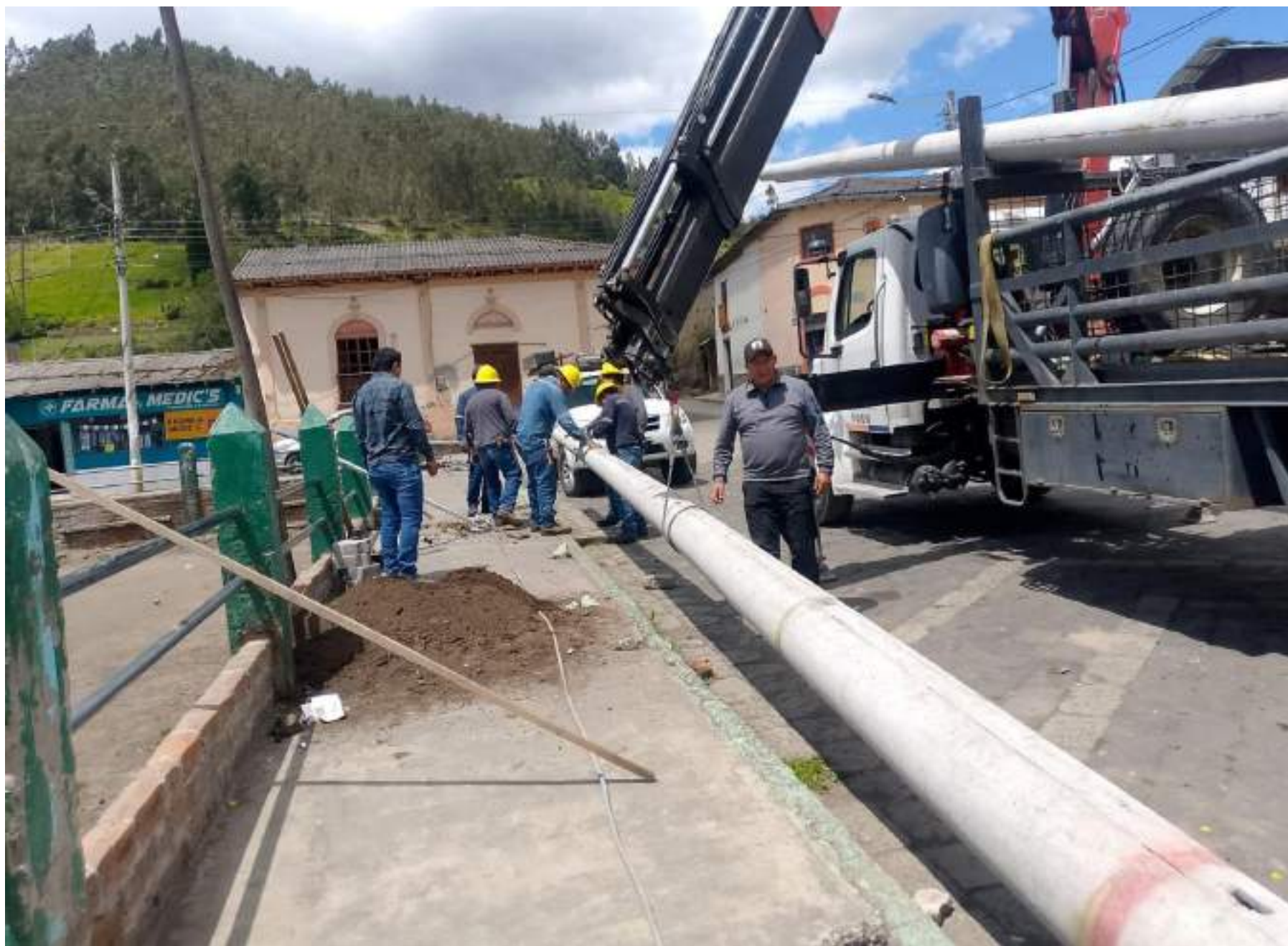
GESTION PARA LA AMPLIACION DEL SERVICIO DE ALUMBRADO PUBLICO EN APUÑAG Y LA PLAZA CENTRAL DE PUNGALÁ, EN COORDINACION CON LA EMPRESA ELECTRICA
