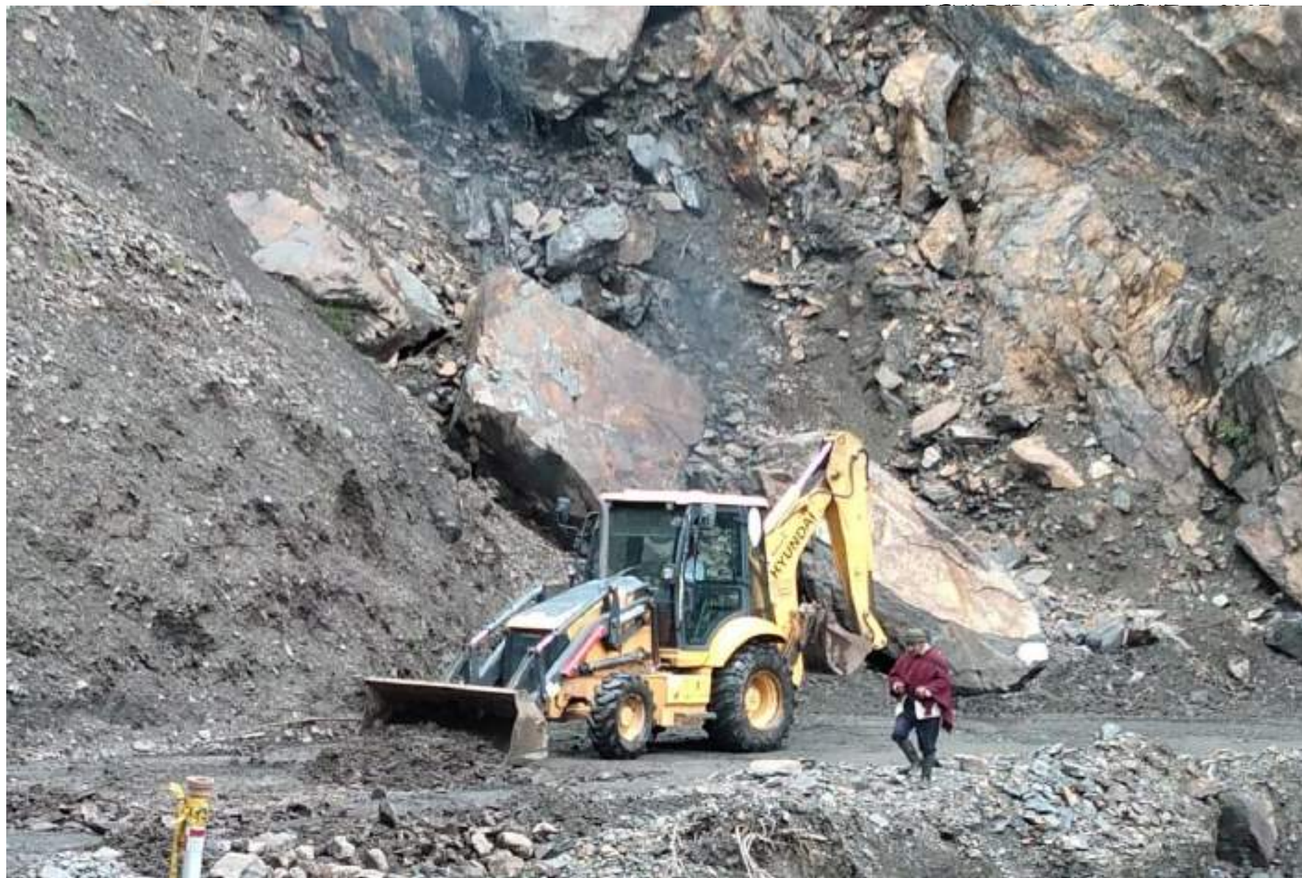
REHABILITACION DE LA VÍA HACIA EL SECTOR ALAO
