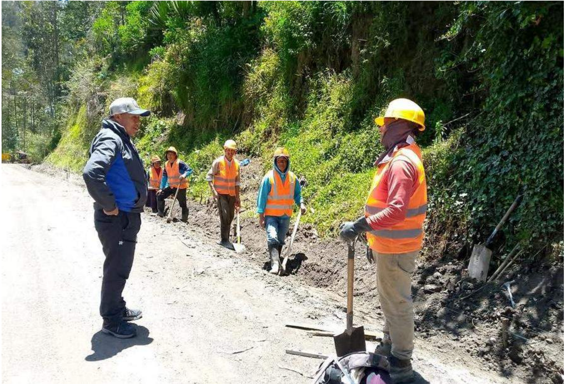
INICIO DEL ASFALTO DE LA VÍA A LA COMUNIDAD DALDAL, EN COORIDNACION CON EL CONSEJO PROVINCIAL DE CHIMBORAZO
