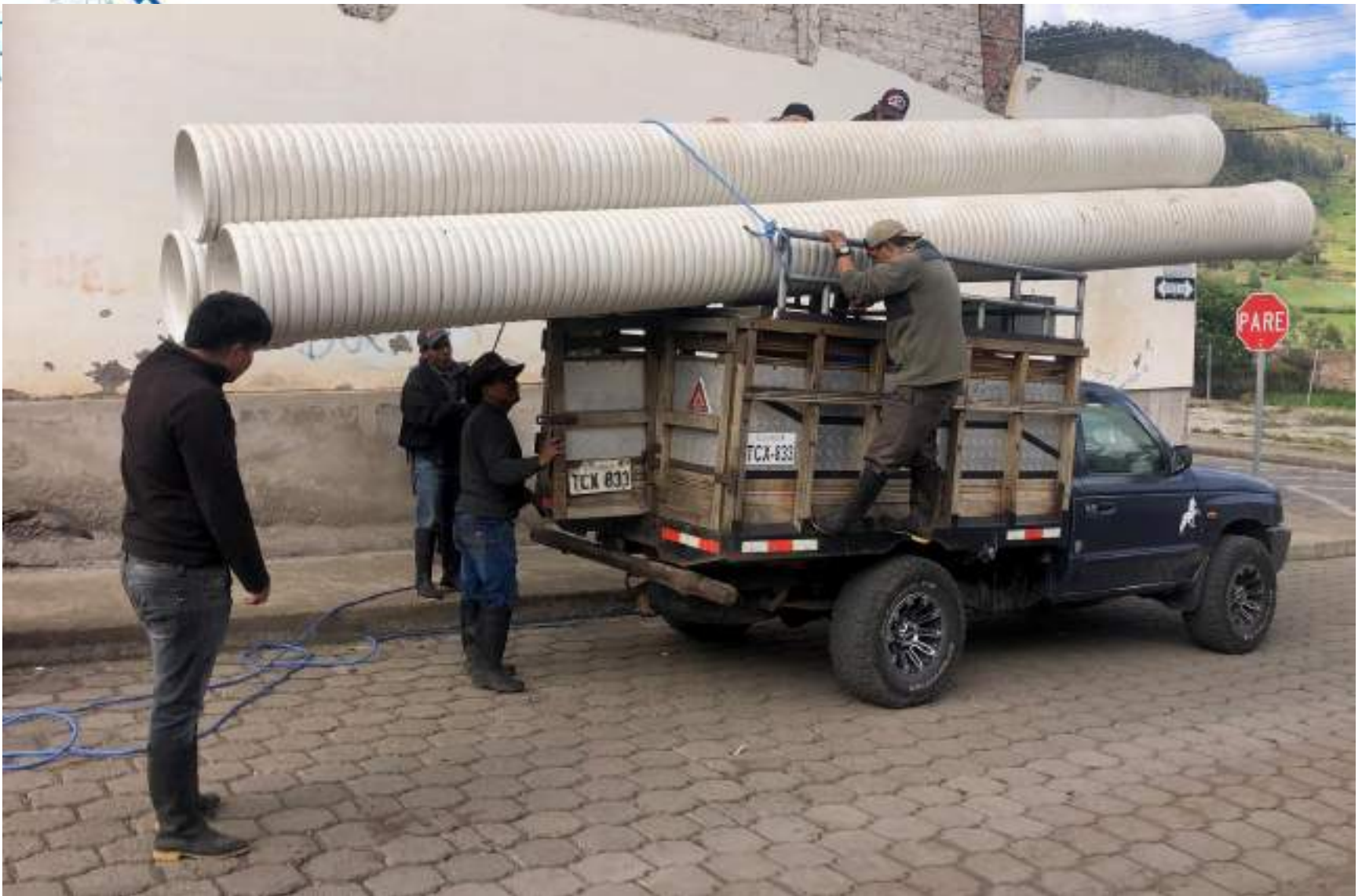
ENTREGA DE TUBERÍAS PARA DRENAJE DE AGUA LLUVIA Y MANTENIMIENTO VIAL EN EL TRAMO PUNGALAPAMBA – CHUSGA Y SECTOR PUNINHUAYCO INVERSION 1230 DOLARES
