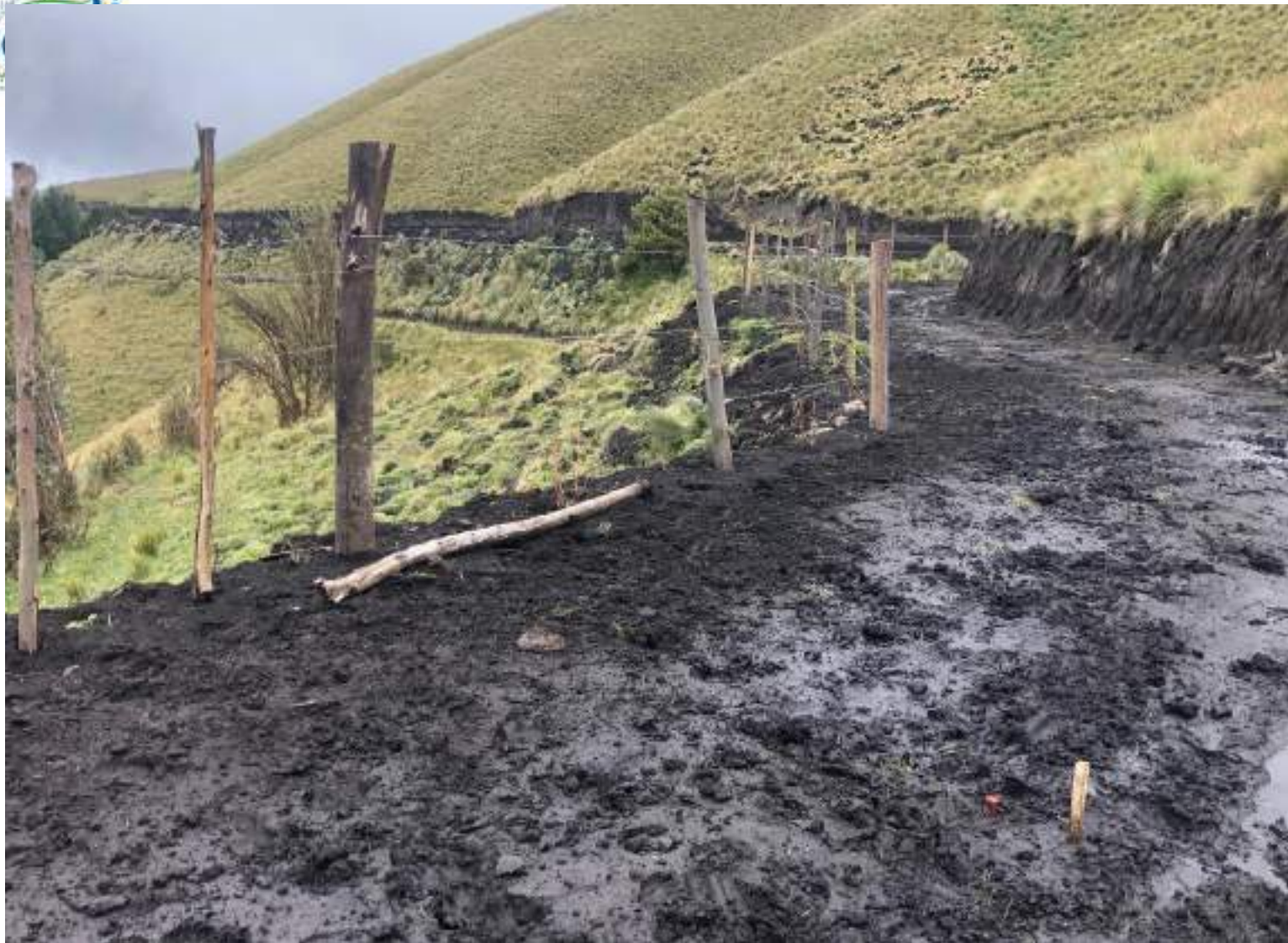
ENTREGA DE TUBERÍAS PARA UN SISTEMA DE RIEGO Y ABREVADERO EN MELAN INVERSION 2925 DOLARES
