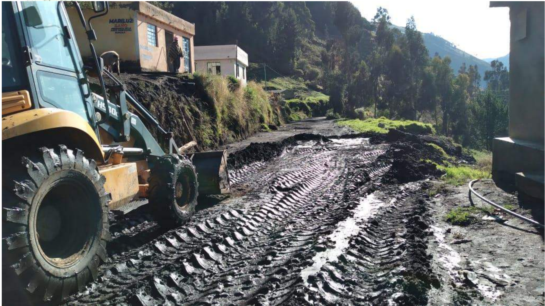
LIMPIEZA Y REHABILITACION DE VÍA EN APUÑAG
