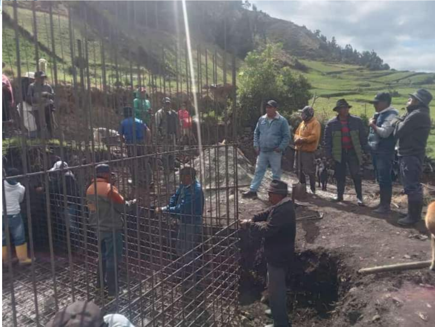
APOYO CON MAQUINARIA Y 50 QQ DE CEMENTO PARA AGUA ENTUBADA EN LA COMUNIDAD DE ALAO LLACTAPAMBA
